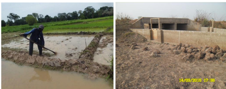
Photo 2 : Quelques méthodes de lutte mécanique dans le marigot de Bignona: endiguement et micro-barrage (Source : Sané, 2015)
