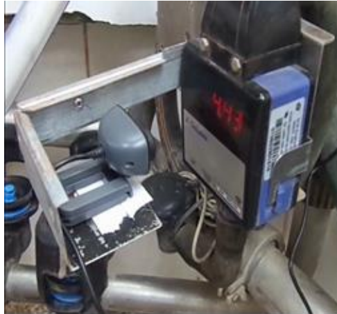
Figura 16. Localización de cámaras
