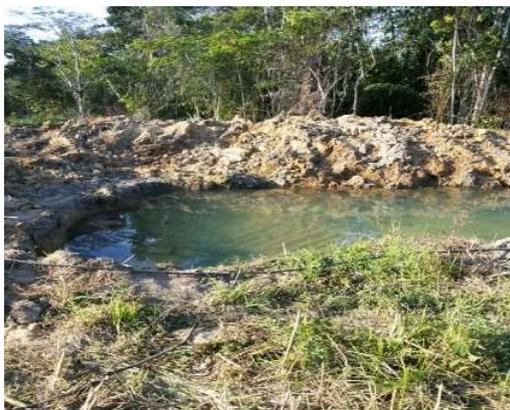
Figura 5: Abertura mecânica de tanque
