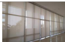
Gambar 22 Solusi desain penambahan window coverings untuk membantu pengendalian jumlah cahaya yang masuk. (digambar : Penulis, 2018)
