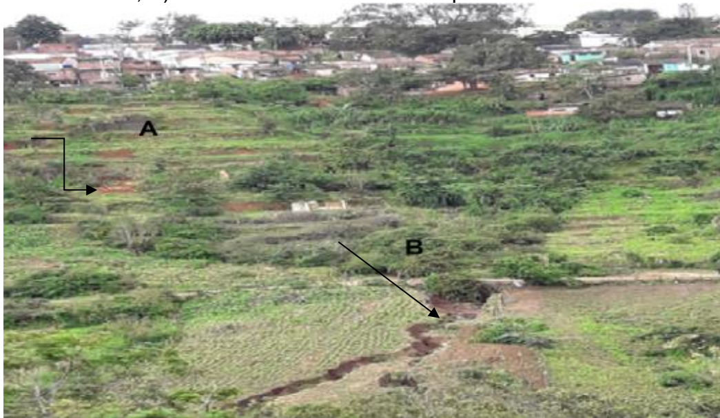
Figura 4 – A) cortes de talude desestabilizando a encosta para construção de residências; B) cicatriz de erosão linear em processo de ravinamento.
