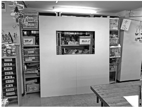
写真5 右側の窓のサイズを仮組みする
