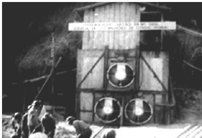
Figura 2. Instalação dos ventiladores no ensaio preliminar.
