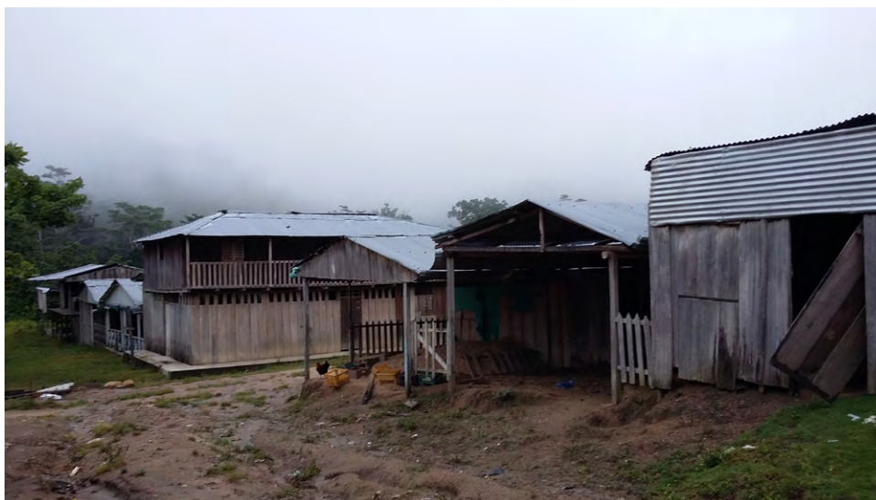
Figura 4. San Juan del río Grande, caserío deshabitado después de las incursiones paramilitares
