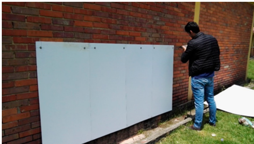
Figura 4. Inicio del montaje con foamboard
