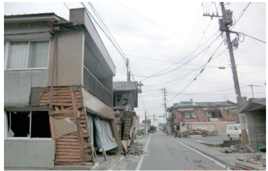
写真1 2016年熊本地震・益城町の建物被害
