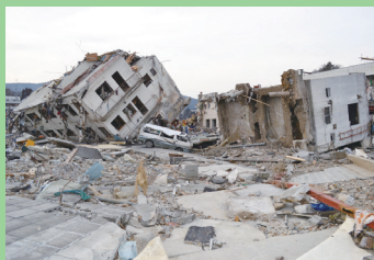
2011年東日本大震災・女川津波被害
