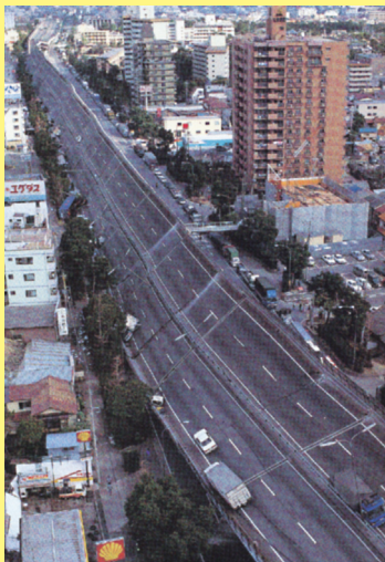
1995年阪神・淡路大震災・高架橋倒壊
