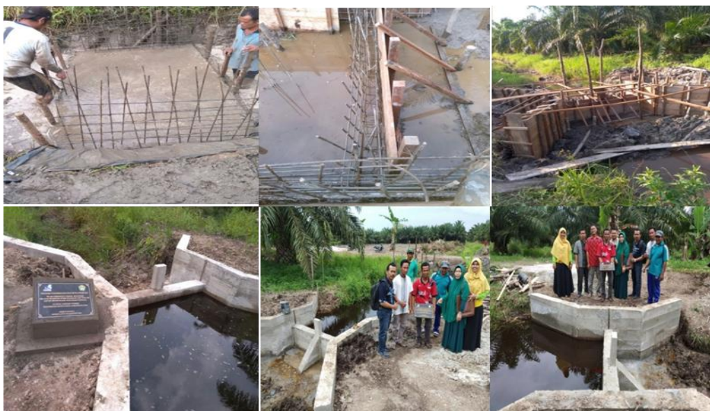
Gambar 3. Tahapan Pembangunan Canal Blocking dan Canal Blocking yang telah Selesai dibangun
