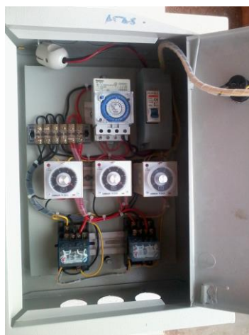
Gambar 4. Rangkaian Timmer Thebben dan Kontaktor
