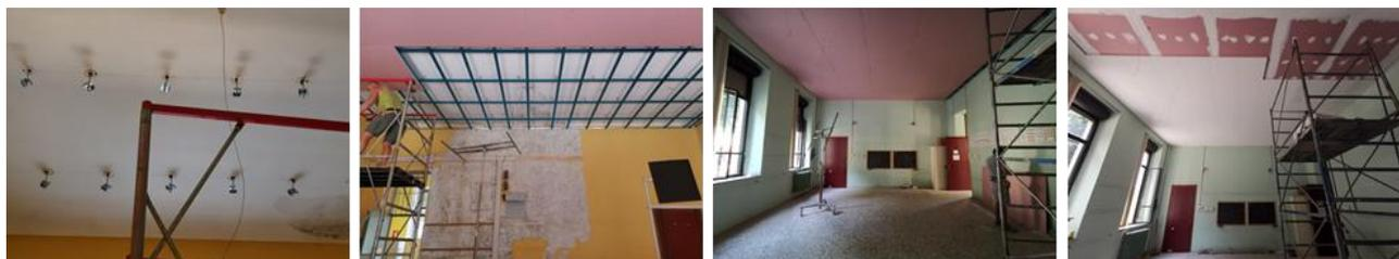
**Figura 2** – Installazione tramite pendinatura e sottostruttura metallica del controsoffitto antisfondellamento Gyproc Fireline e, nell'ultima immagine a destra, dei pannelli fonoassorbenti Ecophon Master™ F in aderenza.
