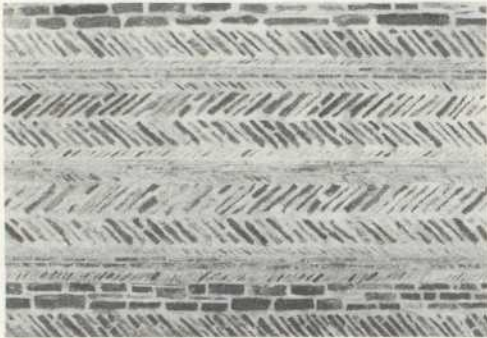
Detail, Steinlagen der Außenmauer
