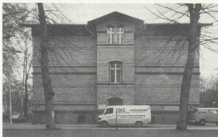
2. Kopfansicht eines bestehenden Stationsgebäudes: Die großen, geschlossenen Wandteile werden lediglich durch profilierte und ebenengleiche Klinkerstreifen gliedert.
