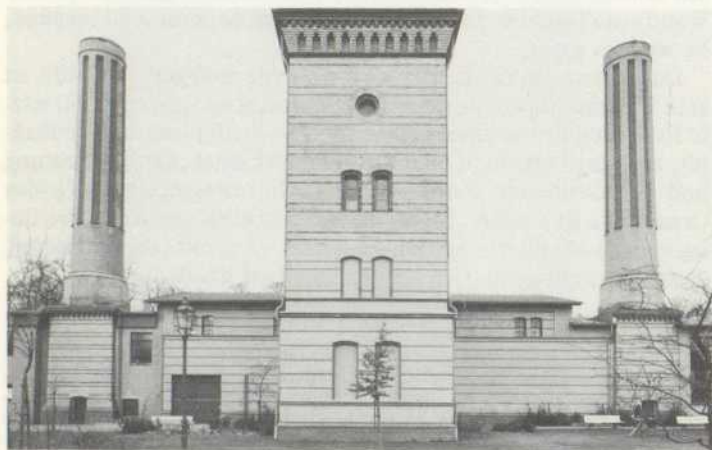
1. Das Heizkraftwerk: Ein monumentaler Sonderbau in der Mittelachse der historischen Anlage. Er wirkt durch das Streifenmuster maßstäblich und als integrales Element der Gesamtanlage.
