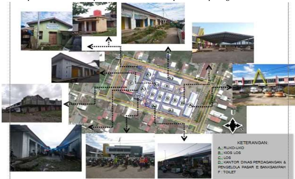
Gambar 2. Kondisi Fisik Bangunan Pasar Sentral Takalar Sumber : Olah Data Primer, 2019
