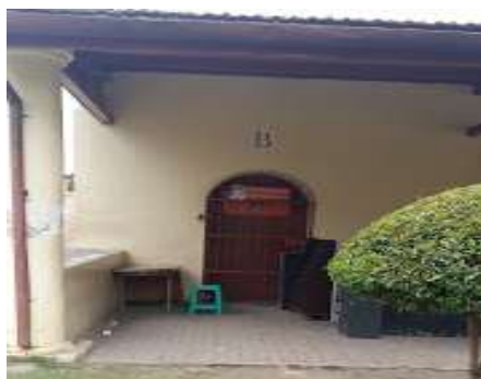
Gambar 5. Gedung B Sumber: Dokumentasi, 2017
