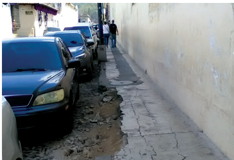
Figura 3. Saturación vehicular y sus efectos en la infraestructura urbana. La Antigua Guatemala durante la Semana Santa, de María E. Molina, abril 2017.
