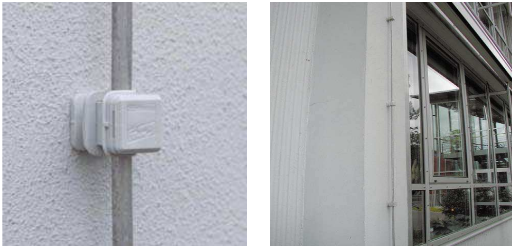
Figura 24. Detalle de conexión bajantes (FUENTE: http://powercol.com )
