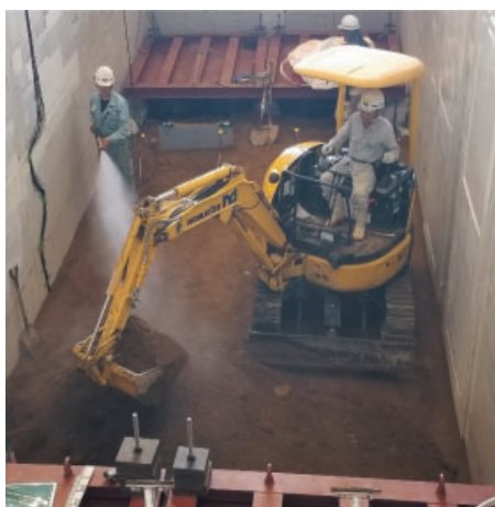
写真 15 散水の様子 Photo 15 Watering situation.
