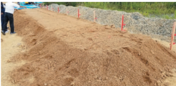
写真 12 試験盛土の様子 Photo 12 Situation of test embankment.
