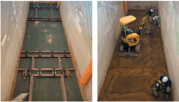
(a) アンカー取付基礎の設置 (b) 基礎地盤施工
