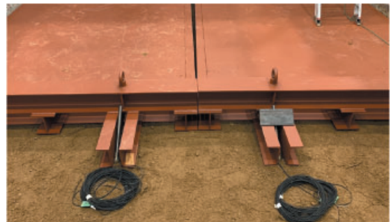
写真 25 下部基礎部アンカーのひずみゲージの貼り付け
