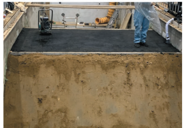
(b) 簡易舗装施工 ( t = 5 cm)
