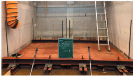
(c) 支圧板下枠を設置およびアンカーの固定
