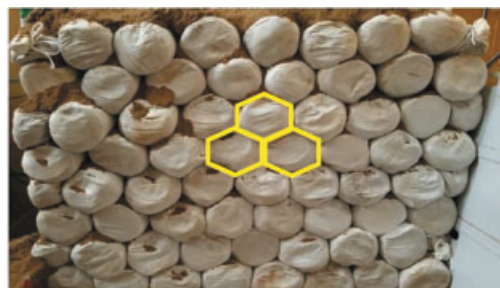
写真 7 法先補強に用いた土のう構造体 (プレストレス 75 \text{ kN/m}^2 ) 18)
