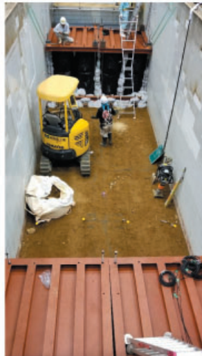
(e) 支圧板上枠を設置
