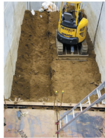
(a) トレンチ掘削の様子
