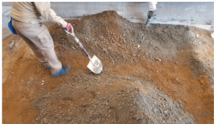
(b) 盛土の天端
