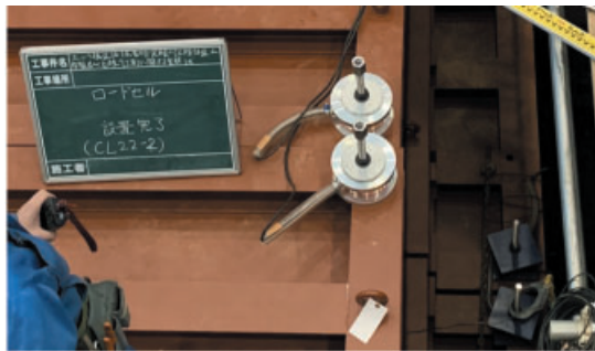
写真 23 荷重計の設置
