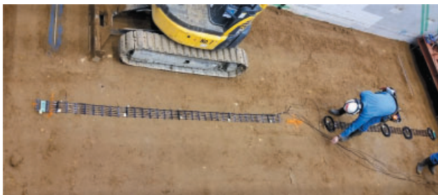
写真 24 すべり面推定用のひずみゲージの設置 (7層目, H=1.75 m)
