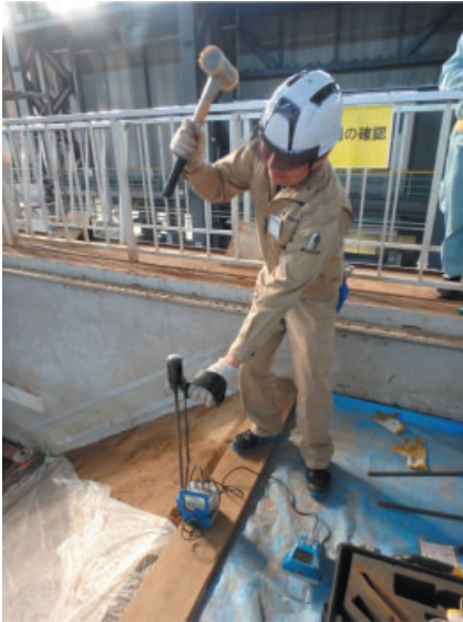
写真 33 PANDA の試験状況 Photo 33 Penetration test using PANDA.
