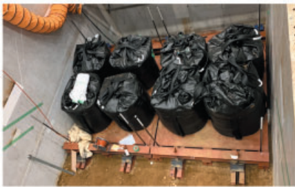
(d) 土のうの設置
