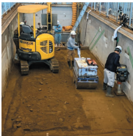
写真 14 ローラーによる転圧状況 Photo 14 Situation of compaction by roller.
