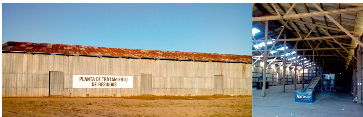
FIGURA 7 ANTIGUO GALPÓN DE ACOPIO DEL FERROCARRIL OESTE, ACTUAL PLANTA DE TRATAMIENTO DE RESIDUOS
