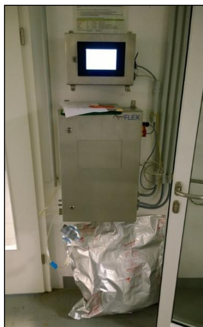
Abbildung 7: Stationäre Biogasanalyse Awi Flex Serie 7
