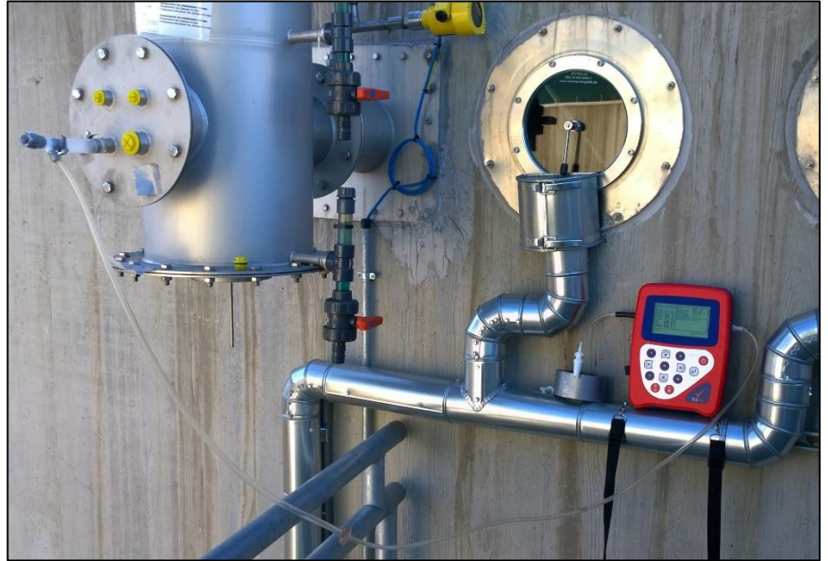
Abbildung 11: Probenahmestellen an den ÜUDS der jeweiligen gasdichten Gärbehälter (links: am Fermenter BGA 1; rechts: am Gärrestlager BGA 6)
