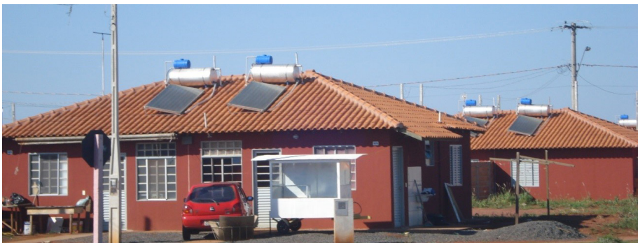
Figura 3 - Uso comercial no espaço da garagem
