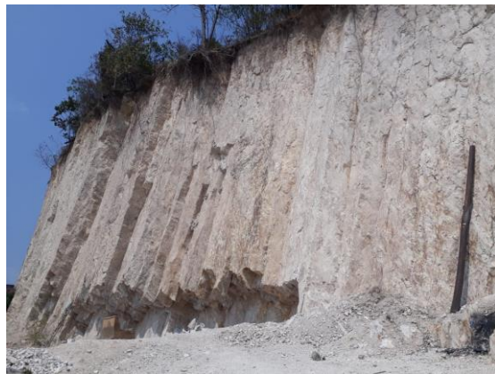
Gambar 2. Menunjukkan kawasan lokasi yang memperlihatkan keadaan lereng yang curam serta mempunyai set kekar yang rapat
