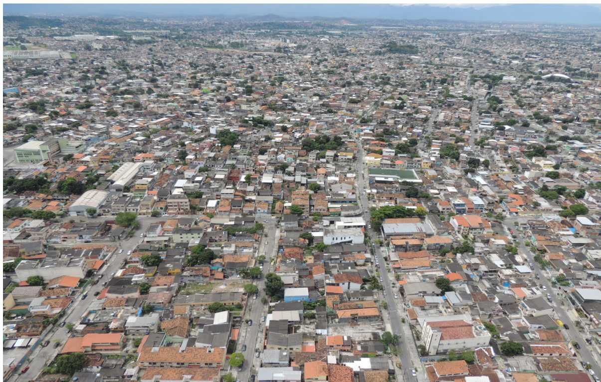
Figura 10 – Elevada impermeabilização do solo e ausência de arborização em trecho de bairro da AP3. Fonte: Acervo do SEL-RJ, 2017.
