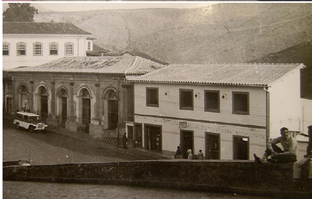
Figuras 6 e 7 – Prédio do Liceu em fase final das obras para cinema, com grande volume na parte posterior; e a solução encontrada por Vasconcellos com a construção de um segundo pavimento em estilo patrimônio na edificação vizinha, em 1959. Fonte: ACI/RJ – Série Obras, Caixa 0218, Pasta 0946.
