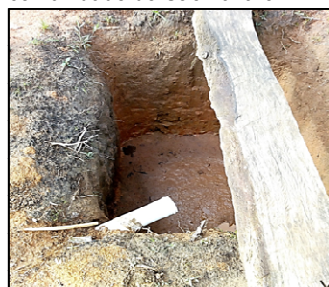
Figura 2 - Fossas negra aberta da comunidade de São Lázaro.
