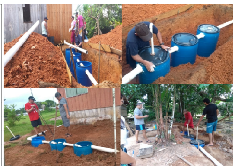
Figura 4 - Fossas sépticas instaladas nas comunidades
