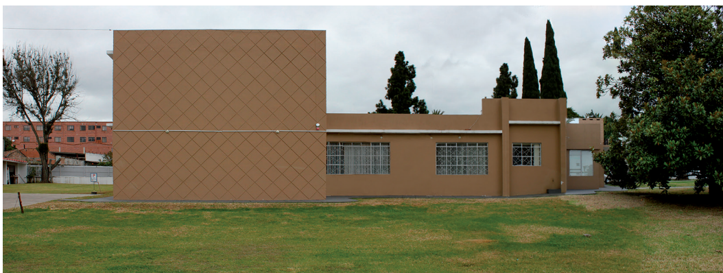
Figura 6: Fachada lateral izquierda del caso estudio relevamiento mediante fotografía rectificadas
