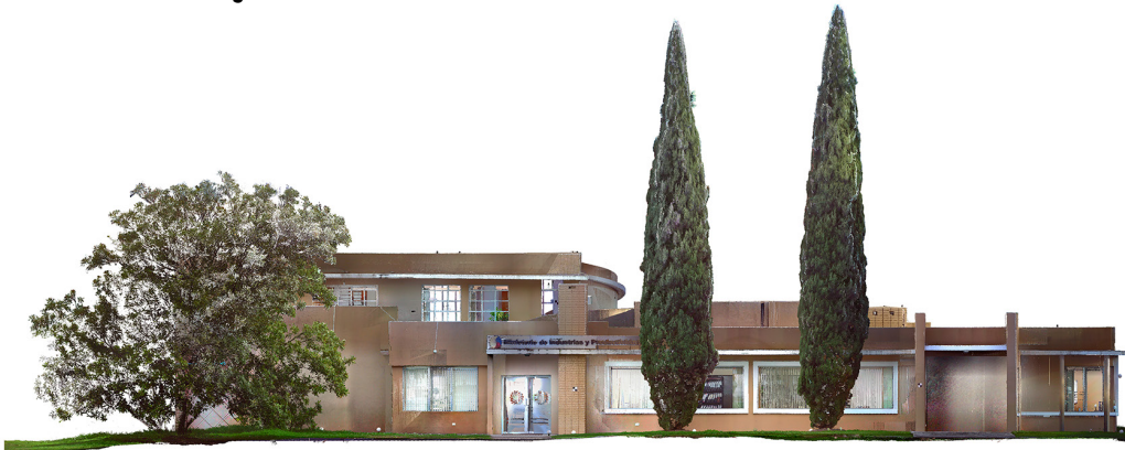
Figura 3: Fachada frontal del caso estudio relevamiento mediante láser escáner
