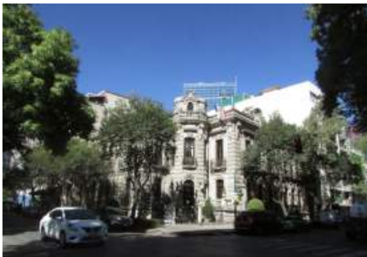
Figura 2 Palacio construido en 1904 Fotografía: Víctor Delgadillo
