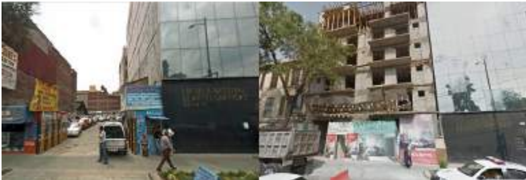
Figura 11 Bucareli 121, de estacionamiento a edificio de departamentos Fuente: imágenes editadas de Google Street View
