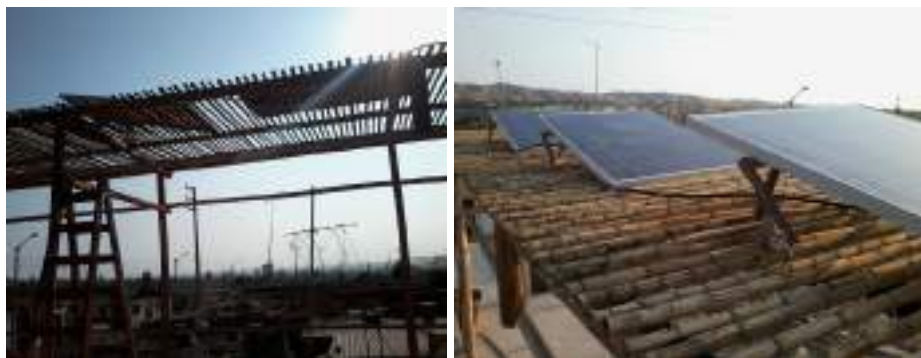
Figura 12 Tres paneles que forman el sistema fotovoltaico instalado en la vivienda Fotografías: Erich Saettone
