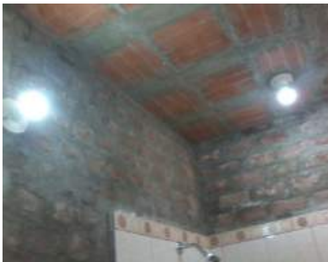
Figura 13 Funcionamiento del sistema de iluminación de la vivienda por energía solar Fotografía: Erich Saettone
