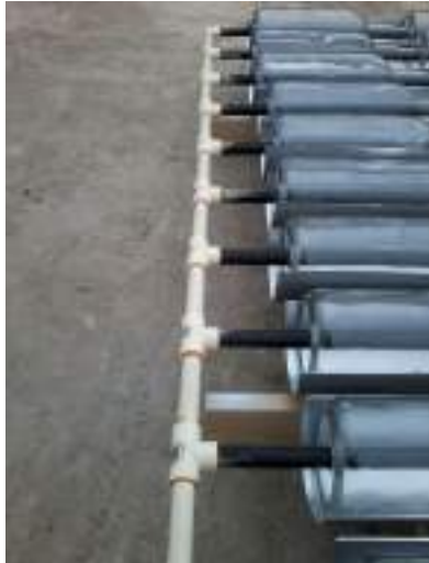
Figura 14 Conexiones de agua, del colector solar con los aislantes térmicos instalados y del aislante térmico instalado para evitar la fuga de calor hacia el ambiente Fotografías: Erich Saettone
