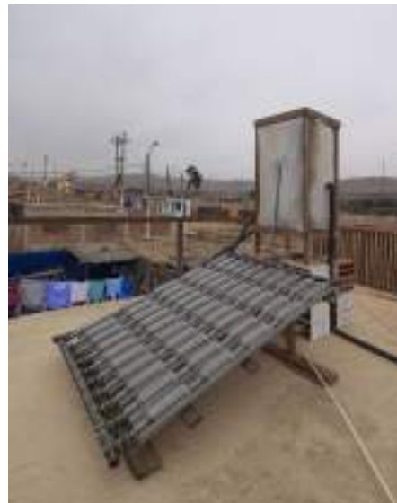
Figura 15 Calentador solar de agua instalado en forma definitiva en la azotea de la vivienda Fotografía: Erich Saettone
