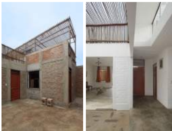
Figura 4 Acabado de ladrillo expuesto que se le dio a los muros exteriores (izquierda) y de ladrillo frotachado y pintado de color blanco (derecha). Fotografía: Juan Solano
