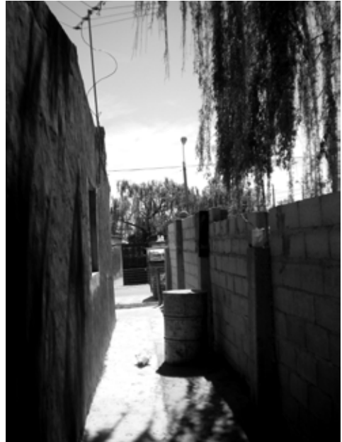
22. Corredor lateral con muro en medianera.
