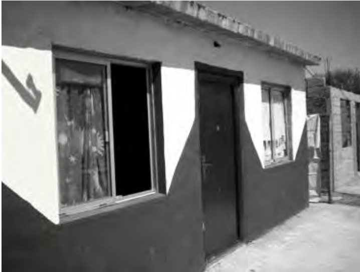
13. Fachada de la nueva vivienda de Juana y José, en el marco del Plan Juntos.
