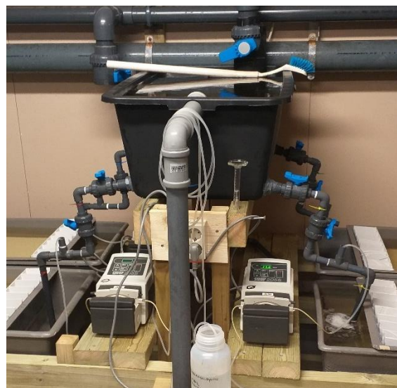
Figur 5. Bildet viser nivåtanken og de fire rørene som fordeler vannet til de fire rennene. Overskuddsvannet inn i nivåtanken går i overløp for å skape en jevn vannføring gjennom rennene.
