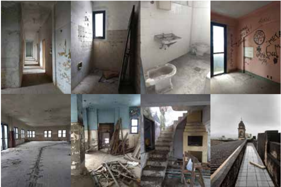
Figura 4 - Imagens internas do Edifício Cauduro.
