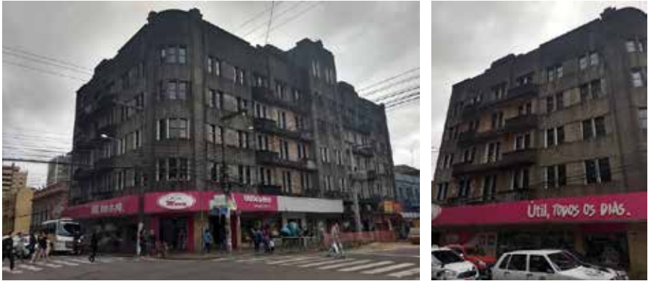
Figura 3 - Imagens externas do Edifício Cauduro.
