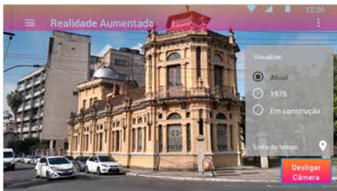
Fig. 11– Prédio do observatório da UFRGS
