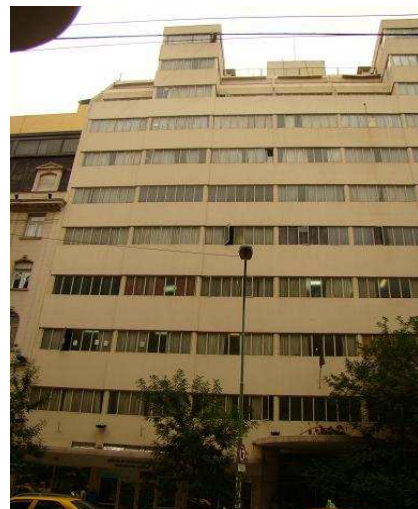
Figura 7. Edificio de la Procuración - Uruguay 440
