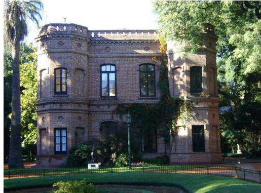
Figura 5. Edificio en el Jardín Botánico – Avda. Santa Fe y Avda. Las Heras
