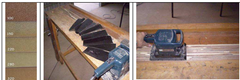
Figura 3: Pulido con lijas de grano sucesivo y lijadora mecánica.
