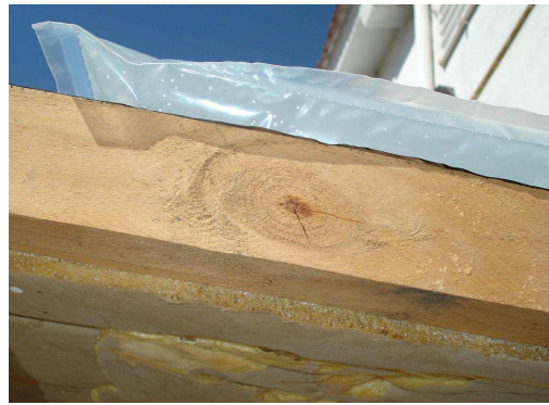
Figura 5: Aislación de poliuretano y marco de madera.
