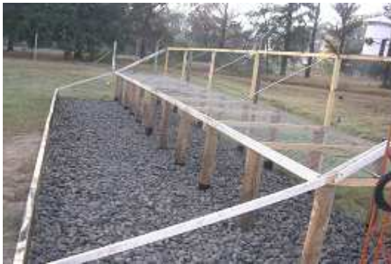
Fig. 2. Vista de la estructura del tendalero modificada
