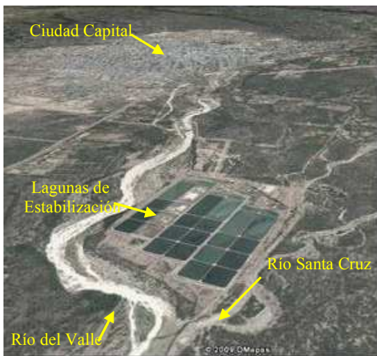
Figura 1. Ubicación de la planta de tratamiento de efluentes cloacales de la Capital de Catamarca. Sistema modular de lagunas.
