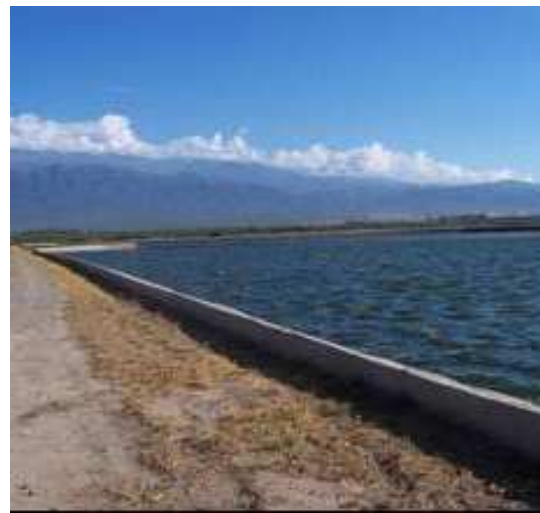
Figura 2. Lagunas de Maduración. Módulo 1 de Sistema de Lagunas de Estabilización de la Capital de Catamarca.
