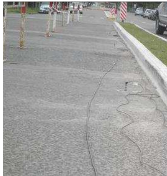
Figura 22: Disposición de los puntos de medición sobre el tablero
