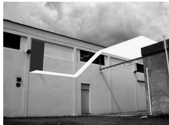
Figura 6: Tecnología metálica y acceso desde el Laboratorio de Ingeniería Civil UTN- FRBA
