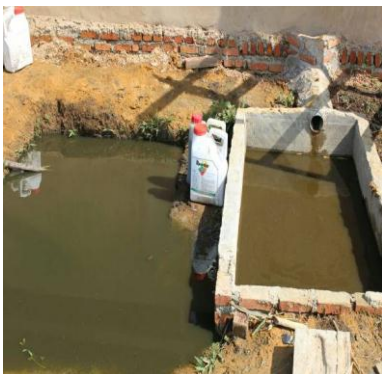
Gambar 4. Bak penampungan urin
