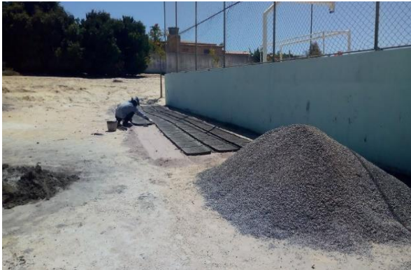
Figura 52 – Construção das placas da cisterna
