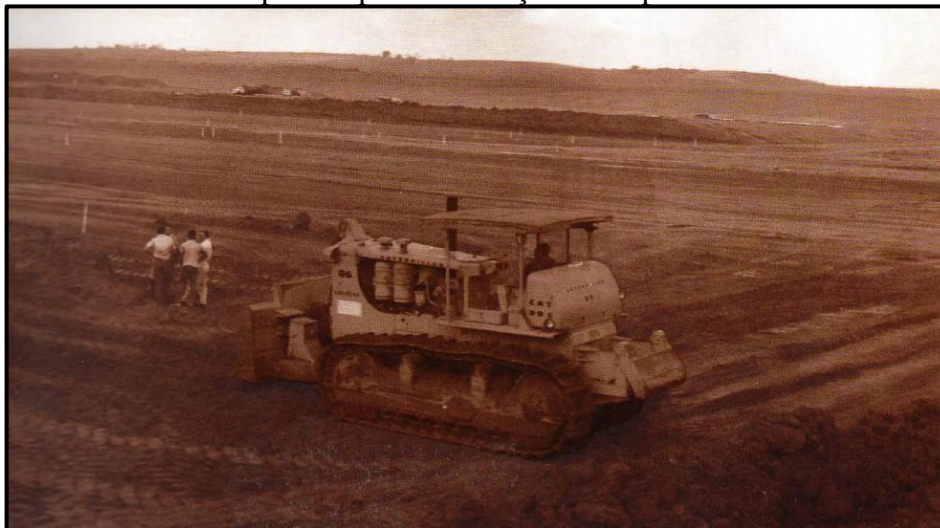
Figura 4.12 - Obras de limpeza e terraplanagem da área doada à Petrobras como ponto de partida para construção da Replan
