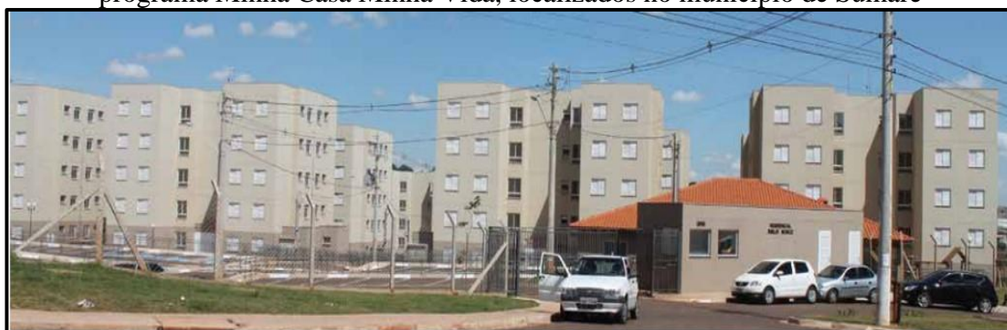
Figura 3.32 - Blocos do Condomínio Residencial Emílio Bosco, construídos por meio do programa Minha Casa Minha Vida, localizados no município de Sumaré
