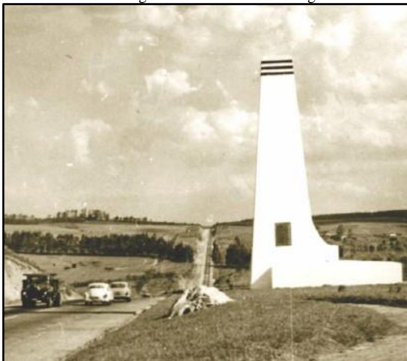
Figura 3.13 - Trecho recém-inaugurado da Rodovia Anhanguera no final dos anos 1940
