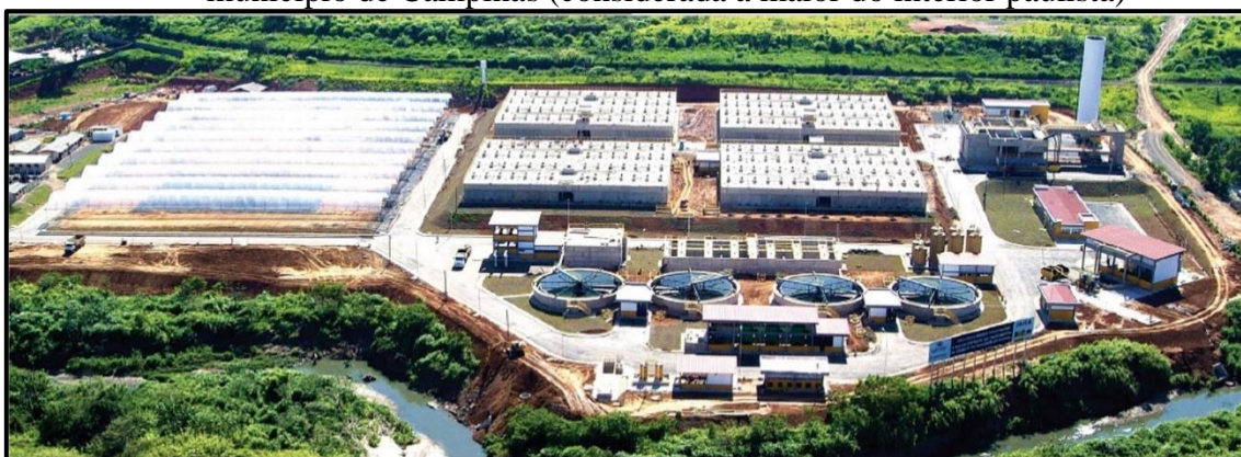
Figura 3.30 - Estação de Tratamento de Esgoto (ETE) do Ribeirão Anhumas localizada no município de Campinas (considerada a maior do interior paulista)
