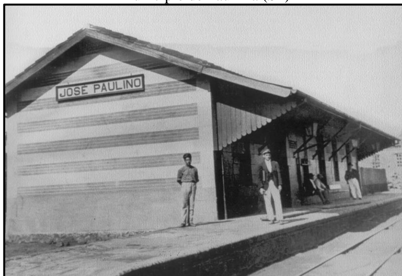
Figura 4.4 - Estação Ferroviária José Paulino localizada em área pertencente ao atual município de Paulínia (SP)
