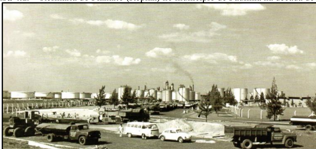
Figura 4.19 - Refinaria do Planalto (Replan) no município de Paulínia na década de 1970
