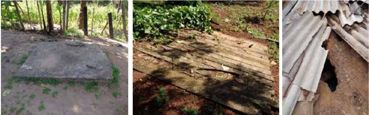
**Figura 2** - Tipos de tampa para fossas rudimentares encontradas em área rural de Campinas (SP). Esquerda - Tampa de alvenaria; Centro - Tampa de madeira; Direita - Tampa com telhas de amianto. (Fonte: Figueiredo, 2019).
