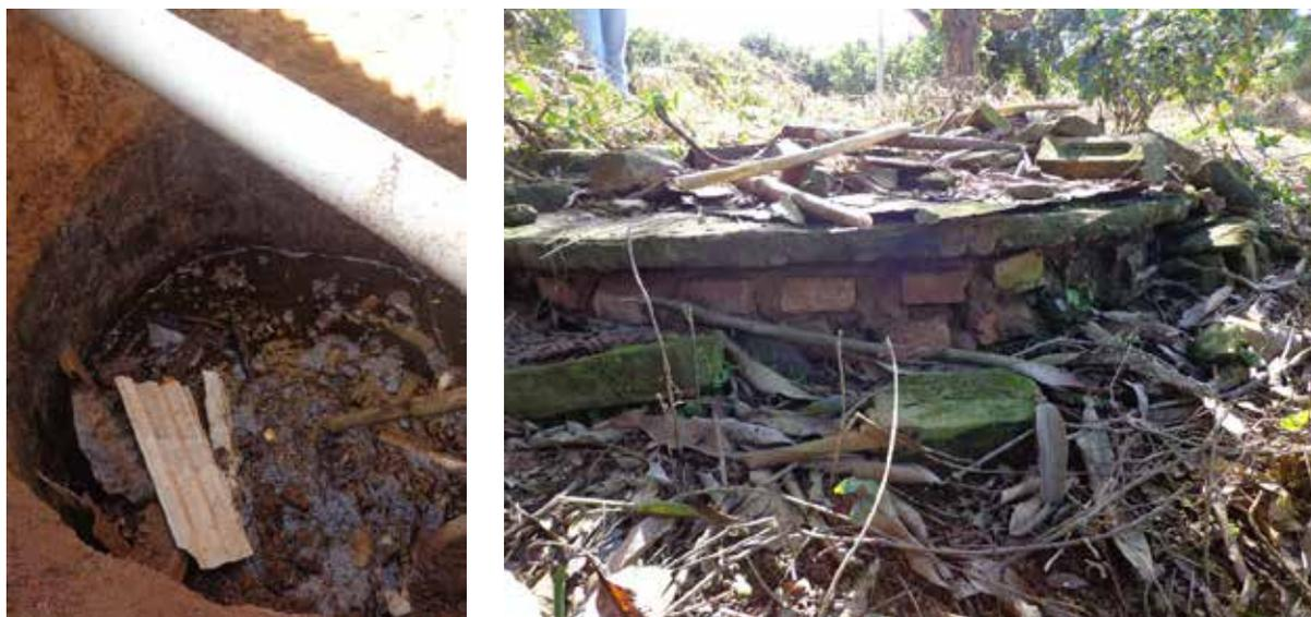
**Figura 1** - Formas de construção das fossas rudimentares em área rural de Campinas (SP). Esquerda - Sem revestimento interno; Direita - Com tijolamento (Fonte: Figueiredo, 2019).
