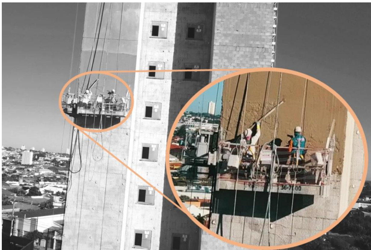
Figura 36. Inspeção de trabalhos de revestimento na fachada
