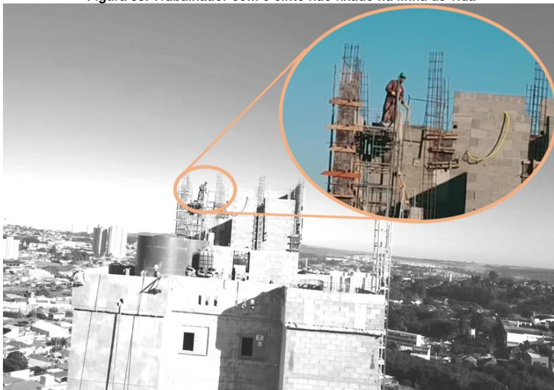
Figura 35. Trabalhador com o cinto não fixado na linha de vida
