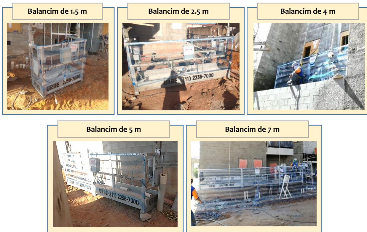
Figura 23. Dimensão dos balancins elétricos
