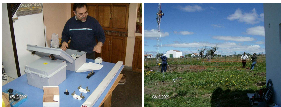
Figuras 3 (izq) – Armado de Tableros y ensayos y (der) Instalación de Torres y molinos 8-12-09
