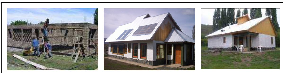
Foto 1: Ejecución de la vivienda.
