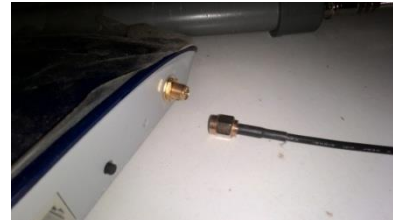
Gambar 10 Menghubungkan Antena ke-Akses Point
