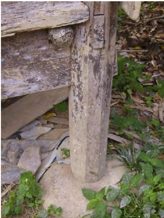
Gambar 7. Umpak tiang lumbung padi. (Sumber: Dokumen Balai Arkeologi Palembang, 2007)
