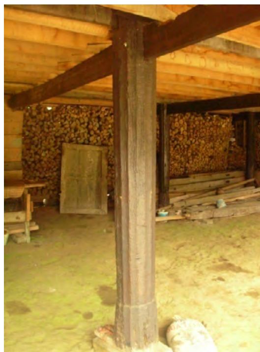
Gambar 5. Tiang yang menembus lantai rumah. (Sumber: Dokumen Balai Arkeologi Palembang, 2007)
