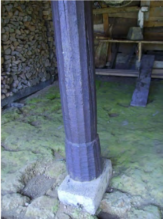
Gambar 6. Tiang rumah dan umpak. (Sumber: Dokumen Balai Arkeologi Palembang, 2007)
